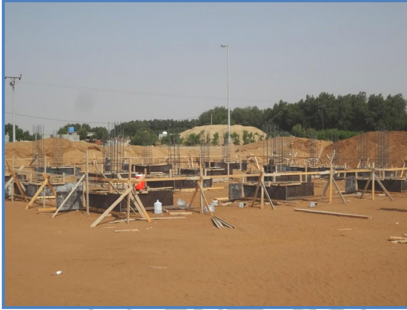
صور لشد الحديد والأخشاب لعمل القواعد واللوحة الحديدية للمشروع
