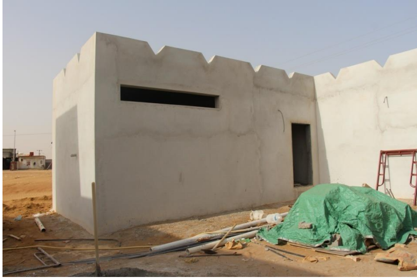
صورة أعمال اللياسة الخارجية لدورات المياه
