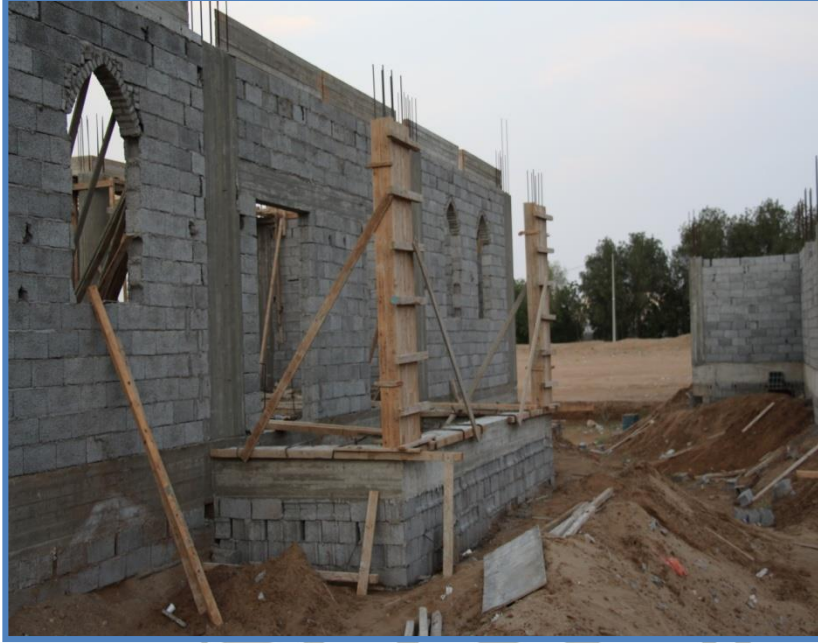
صورة الانتهاء من المباني وشد أعمدة المحراب
