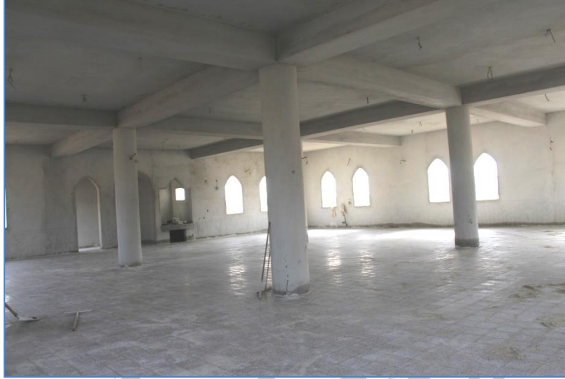
صورة الانتهاء من تركيب بلاط أرضية الجامع
