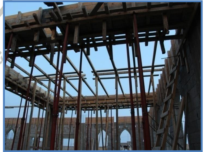
صورة أعمال بداية شد الأخشاب لصب السقف
