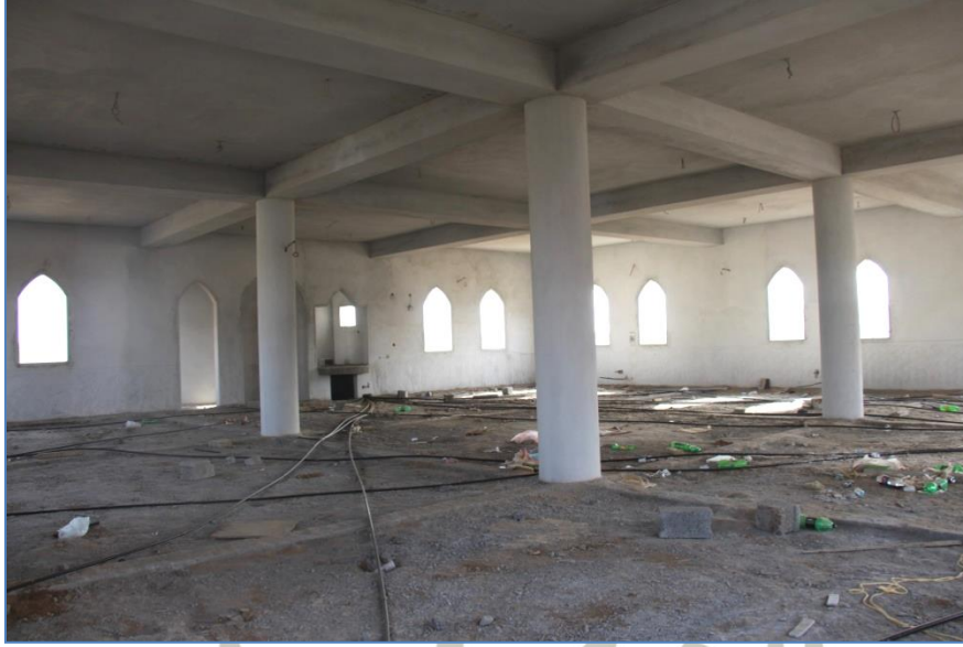
صورة أعمال اللياسة الداخلية للجامع
