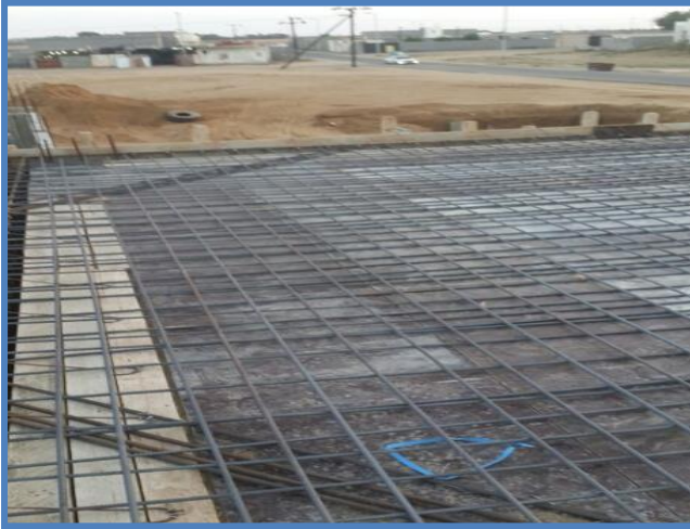
صورة شد الحديد والأخشاب لصب السقف
