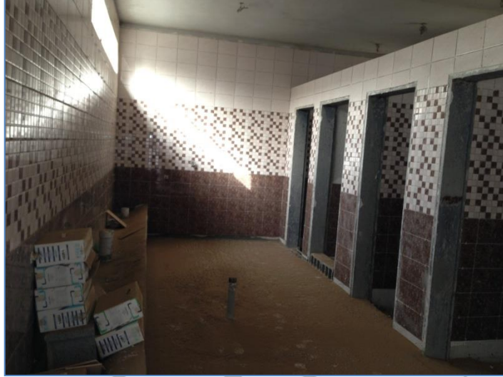
صورة الانتهاء من تركيب بلاط الحائط لدورات المياه
