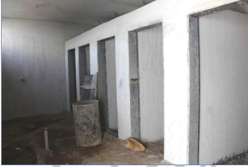
صورة أعمال اللياسة الداخلية لدورات المياه
